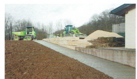
Fachgerechter Unterbau mit Drainage und Entwässerungsrinne am neuen Platz, rechts Aufbau des neuen Erdwalls mit vorhandenem Bodenmaterial
