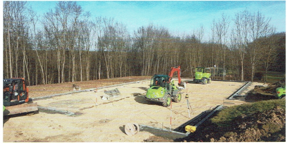
Fachgerechter Unterbau mit Drainage und Entwässerungsrinne am neuen Platz, rechts Aufbau des neuen Erdwalls mit vorhandenem Bodenmaterial
